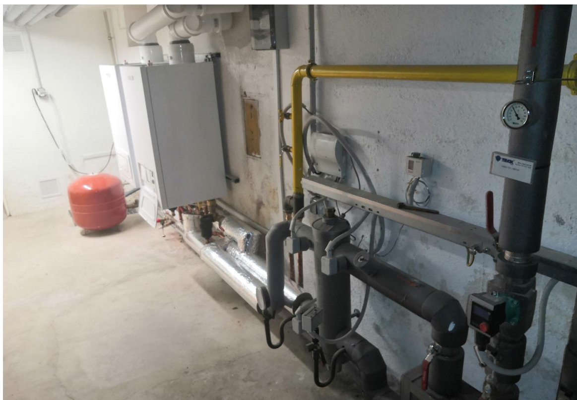
Foto č. 1 – Pohled na stávající kondenzační kotle a HVDT
