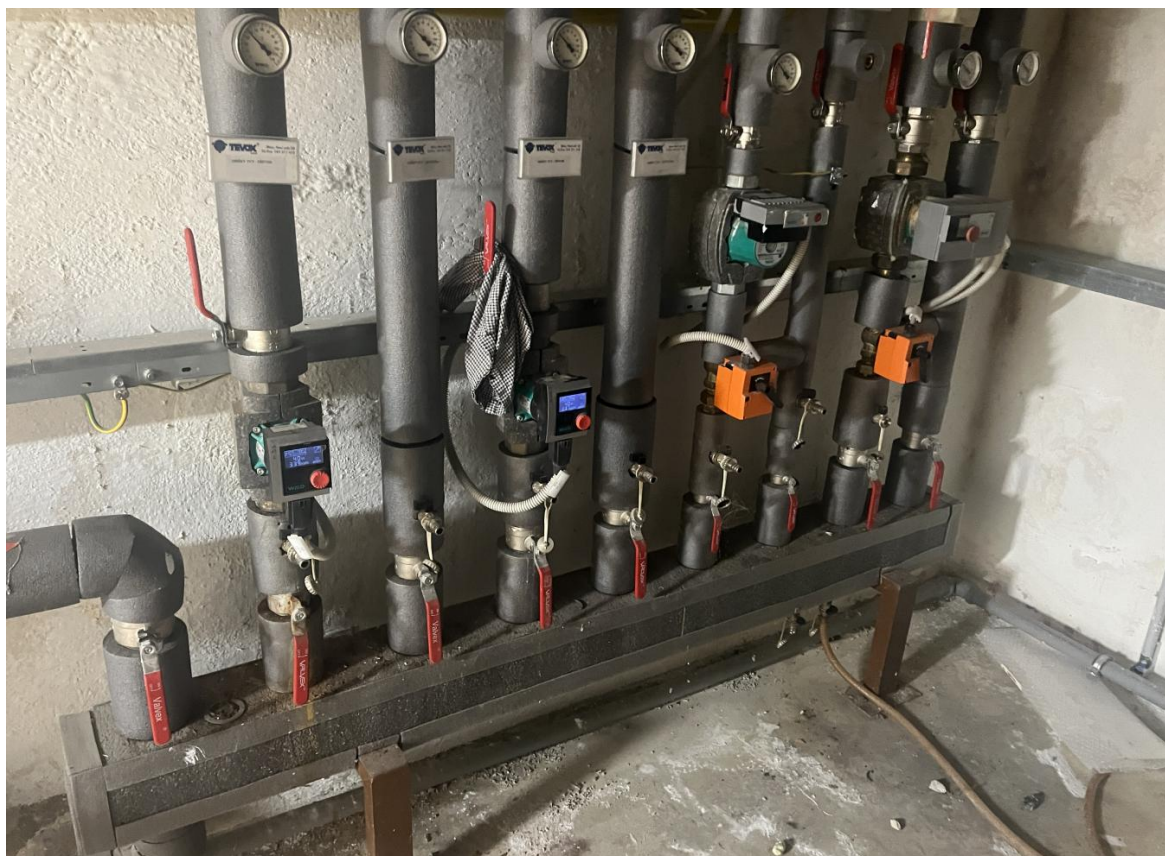
Foto č. 2 – Pohled na stávající kombi rozdělovač
